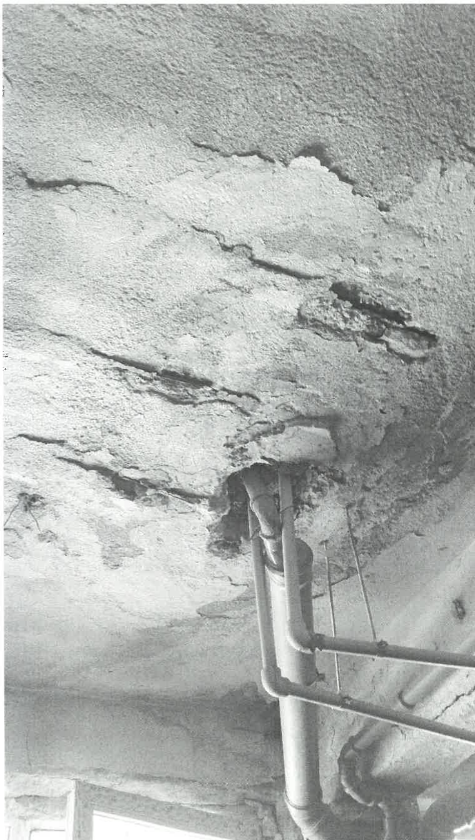
5. Corpul de cladire S+P+E1+E2restrans.- placa planseu degradata sub bazin kinetoterapie.
