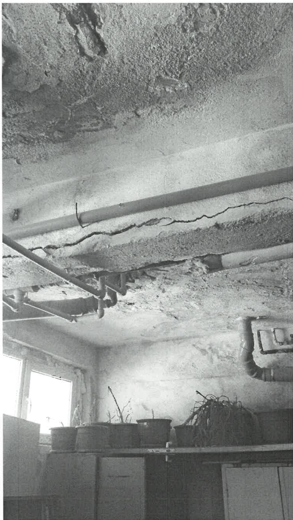
4. Corpul de cladire S+P+E1+E2restrans.- grinda planseu degradata sub bazin kinetoterapie.
